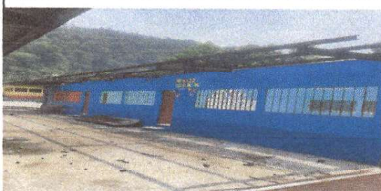
Foto 4: desinstalacion de lámina de los dos módulos
