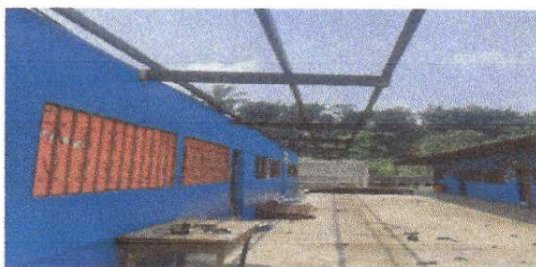
Foto 1: desinstalación de lámina existente módulo 1
