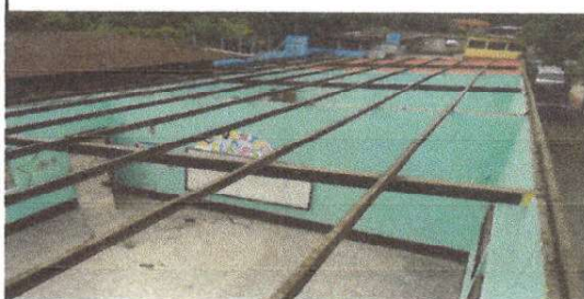
Foto 2: desinstalación de lámina existente módulo 2
