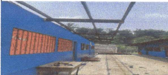
Foto 6: desinstalación cubierta de lámina
