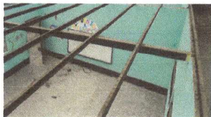
Foto 5: mantenimiento a estructura de metal
